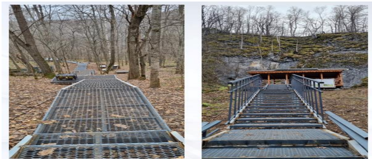
Рис. 2. Металлическая лестница, установленная на подъеме на хребет Улутау, где расположен вход в Аскыную ледяную пещеру
